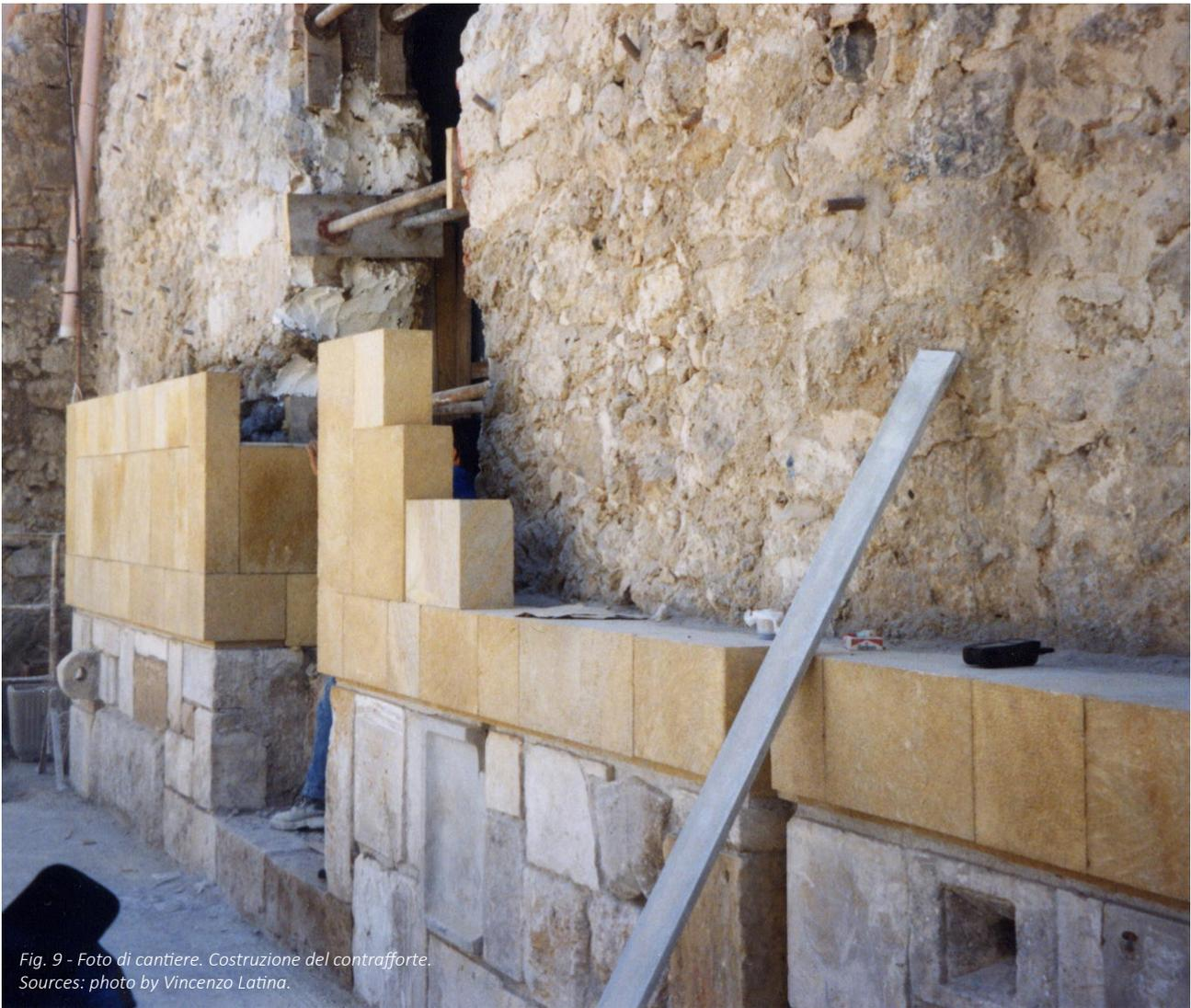
Fig. 9 - Foto di cantiere. Costruzione del contrafforte.
