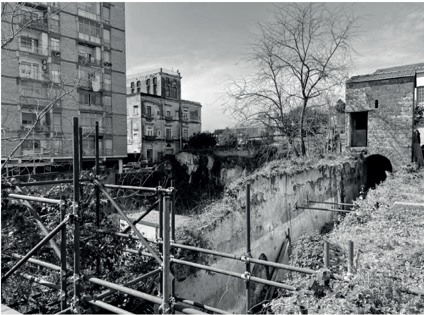
Fig. 4 - Foto del Canale del Conte Sarno da Villa A verso il lotto dove sarà realizzato il Visitor Centre, 2024.
